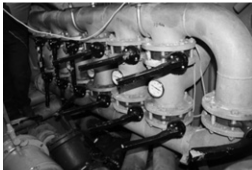
Rys. 2. Widok ładowni: a) suchej kutra rybackiego, b) mokrej kutra rybackiego oraz c) część instalacji rozprowadzania wody schłodzonej na kutrze rybackim [8]
