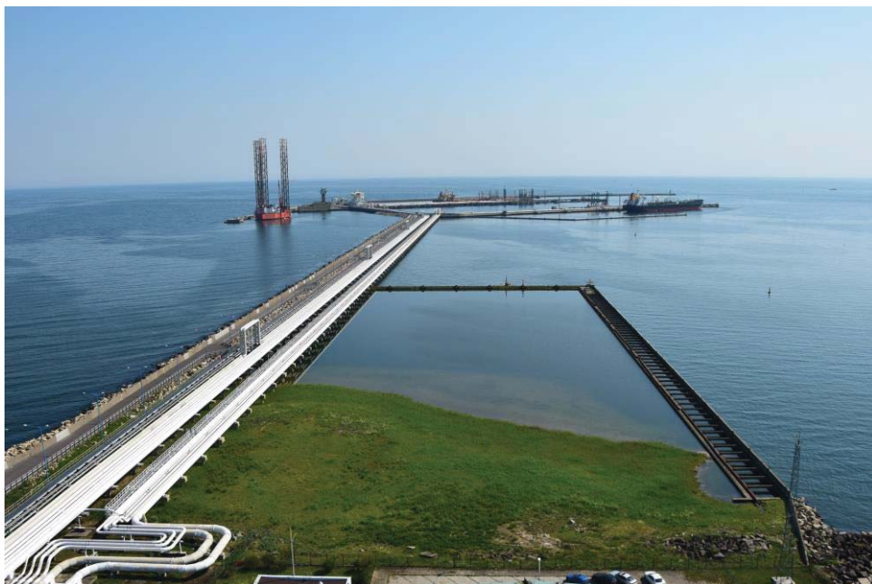
Rys. 5. Gdańsk Port Północny – widok istniejących konstrukcji w sąsiedztwie obszaru planowanej inwestycji – stan obecny; od lewej: Falochron Półwyspy Północny obok estakady rurociągów paliwowych, w tle pirsy terminalu paliwowego; u dołu: obudowa I kwatery Pola Refulacyjnego nr 3
