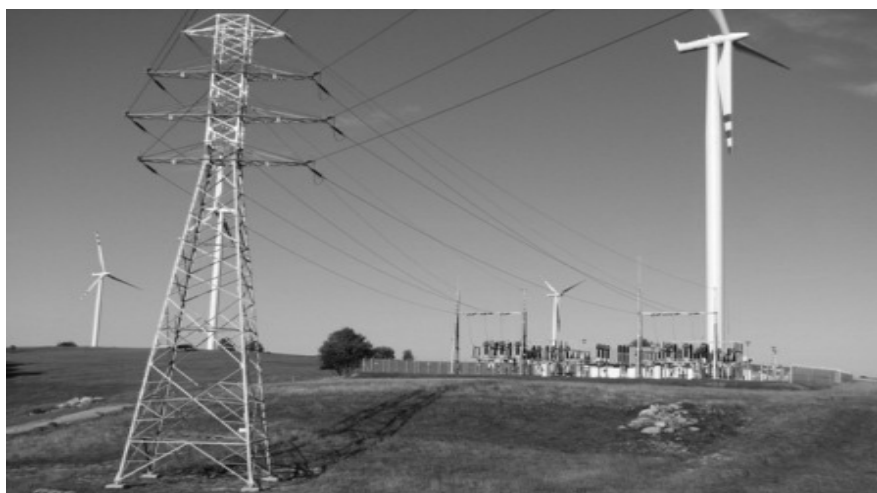
Rys. 1. Wyprowadzenie mocy z farmy wiatrowej za pomocą dwutorowej napowietrznej linii o napięciu znamionowym 110 kV
