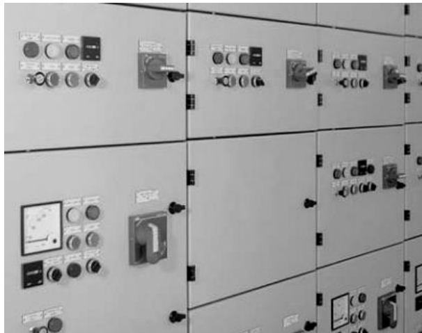
Rys. 4. Przykładowy widok szaf sterowniczych zintegrowanych z rozdzielnicą K-Power [2]
