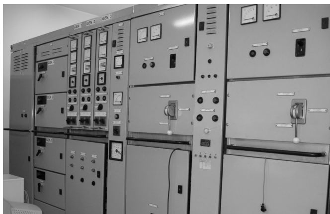
Rys. 1. Okrętowa rozdzielnica RG 103A w Laboratorium Elektroenergetyki Akademii Morskiej w Gdyni
