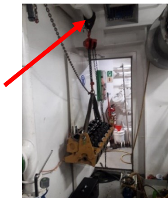
Rys. 5. Transport głowicy za pomocą wciągarek łańcuchowych
