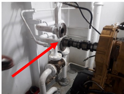
Rys. 4. Rurociągi uniemożliwiające demontaż wałka rozrządu
